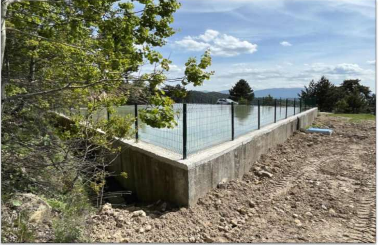
Amasya Gümüşhacıköy Kağnıcı Köyü Sulama Tesisi
