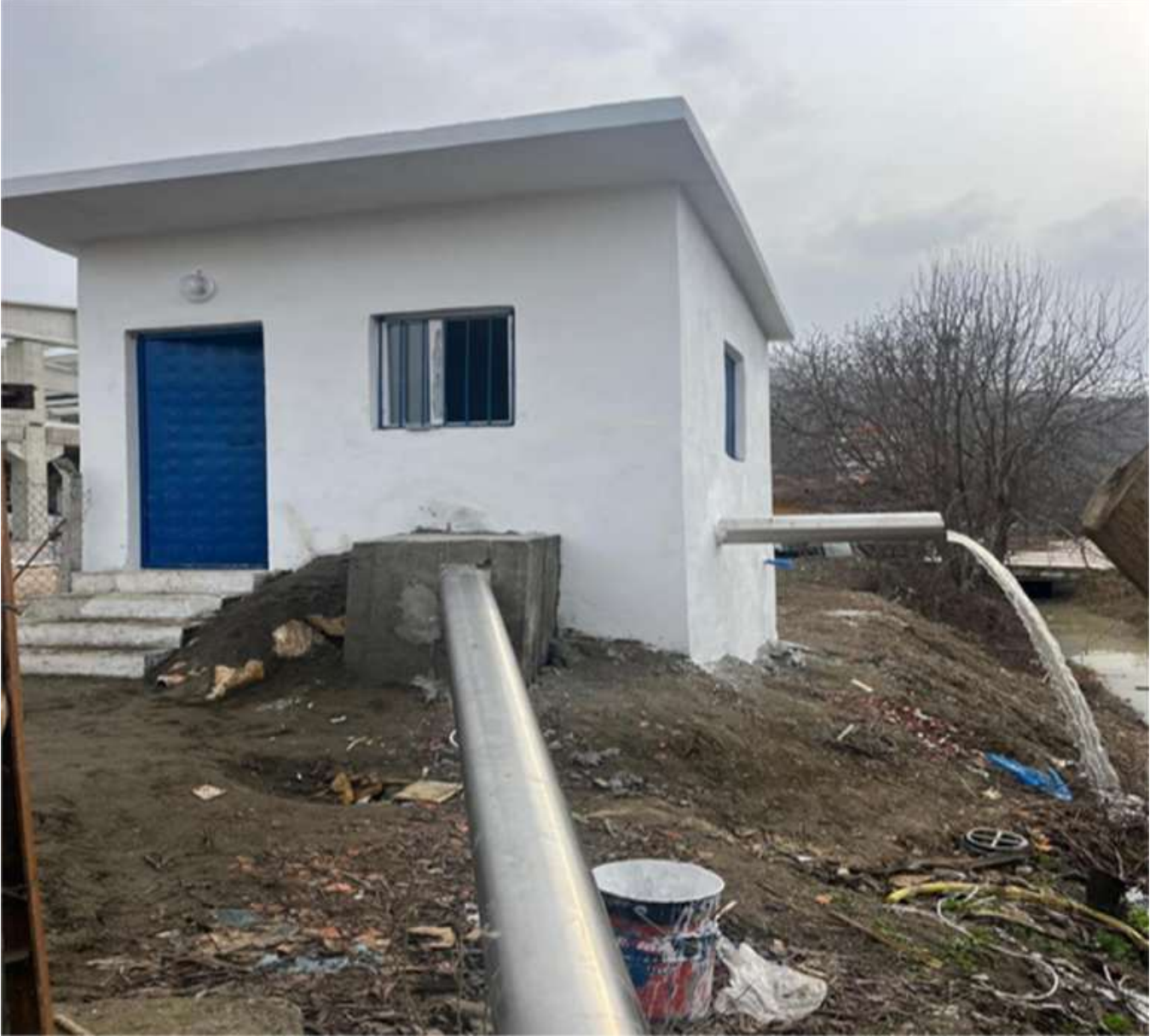
İpekköy Terfi Binası
