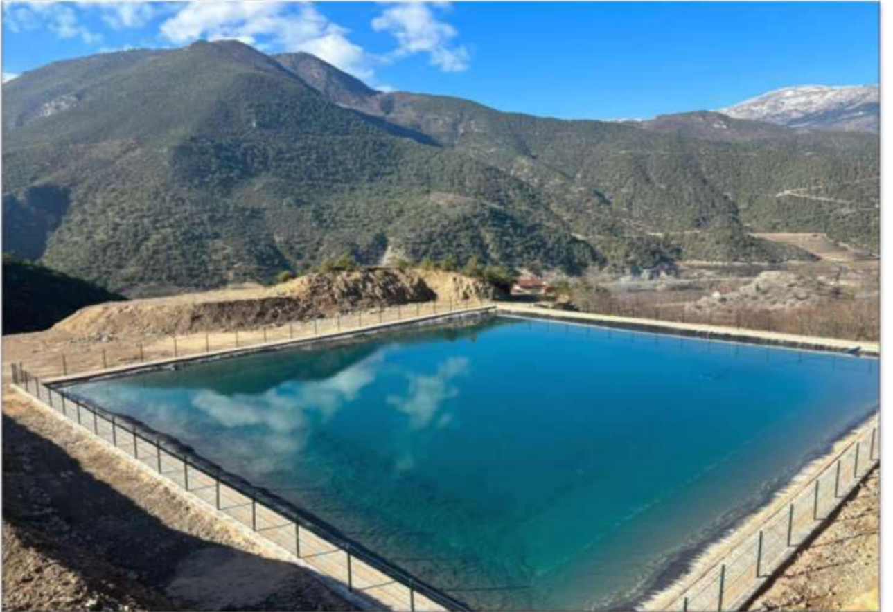
Amasya Merkez Çiğdemlik Köyü Membran Kaplamalı Havuz Yapım İşi
