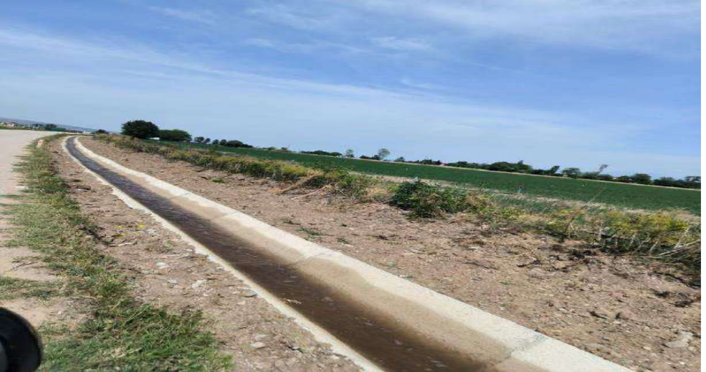
Amasya Merzifon Sazlıca Sulama Tesisi
