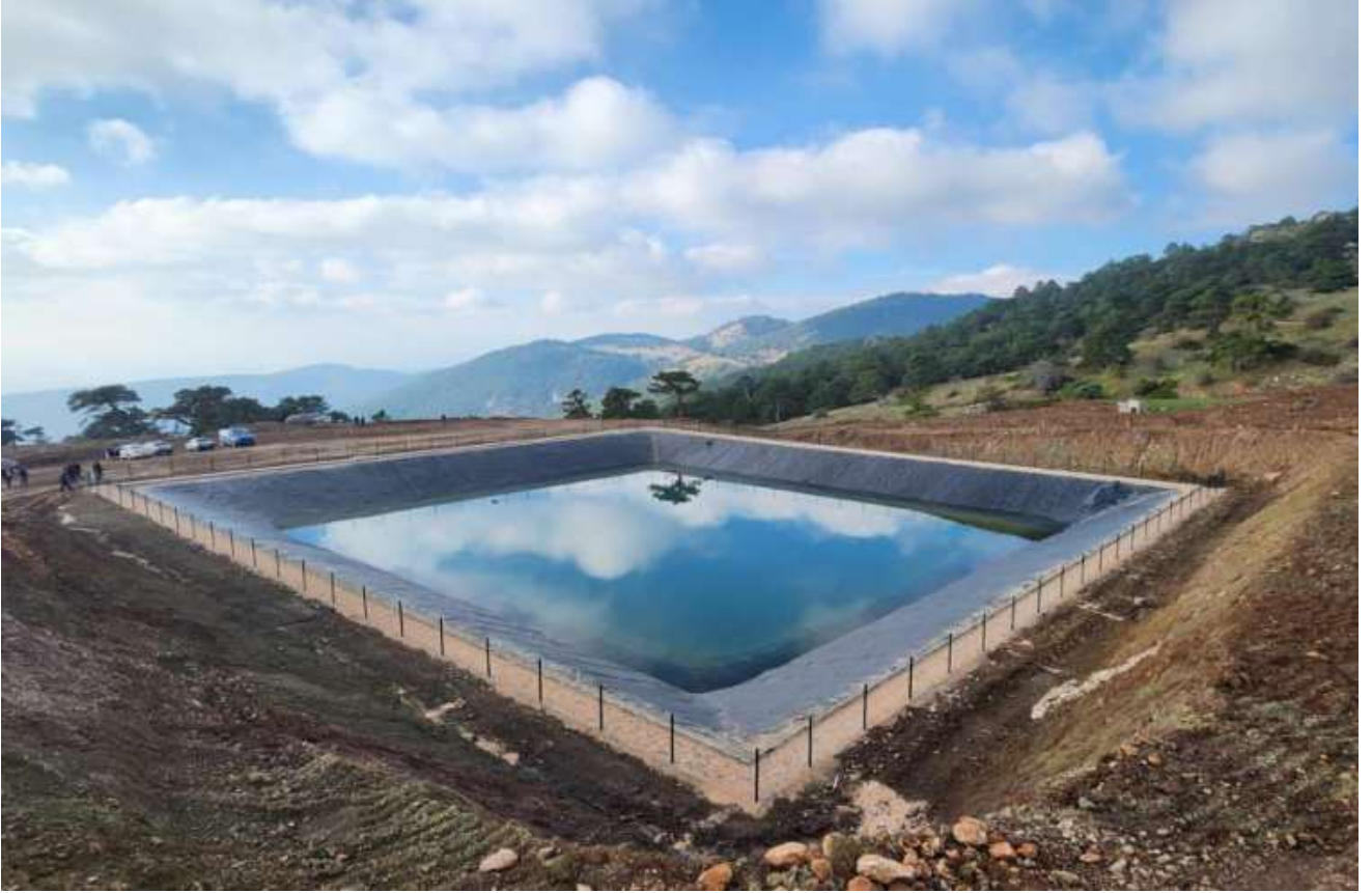
Amasya Suluova Eğribük Membran Kaplamalı Havuz
